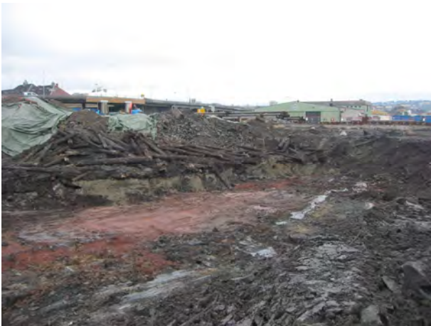
在修復前，先行挖掘受污染的土质
