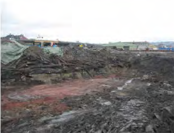
在修復前，先行挖掘受污染的土质
