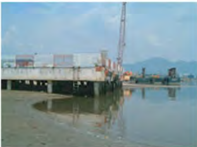
霹雳州红土坎码头工程提升
