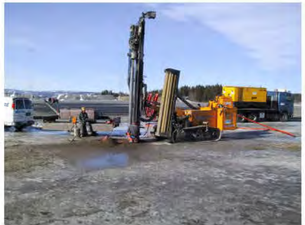
安装地下水井，以评估现场环
